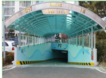
지하주차장 진입로 지붕
