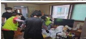
쓰레기 처리 및 방역작업 실시, 도배 및 장판 시공
