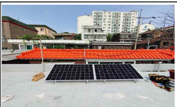
주택 옥상 태양광 패널 설치 사진
