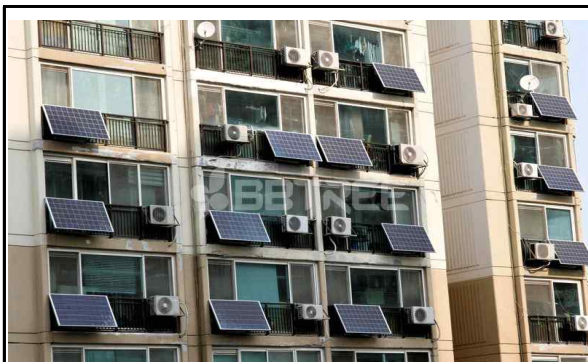
아파트 태양광 패널 설치 사진
